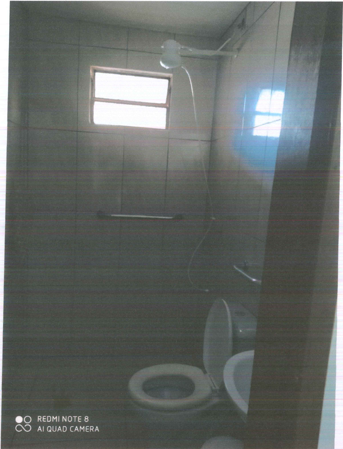
Foto 8 – Banheiro anexo ao quarto
